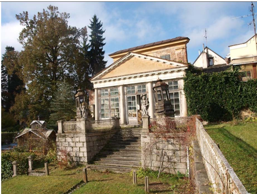
Celkový pohled od parteru
